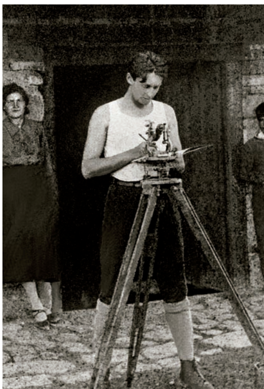
1935 г., Кавказ. Выверка теодолита для высотной привязки маятникового пункта
