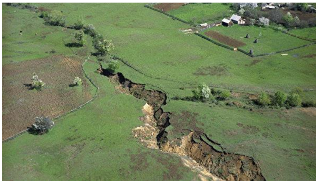
Рис. 28. Трещины отседания склонов на бортах оврага.
