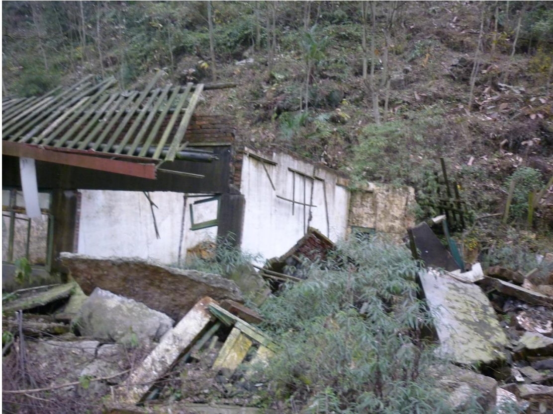
Рис. 17. Развалины дома в деревне Хонгкоу. Видно, что в подножье сейсмогенного эскарпа задняя стена дома смещена правосторонним сдвигом (фотография Е.А. Рогожина, 2010).
