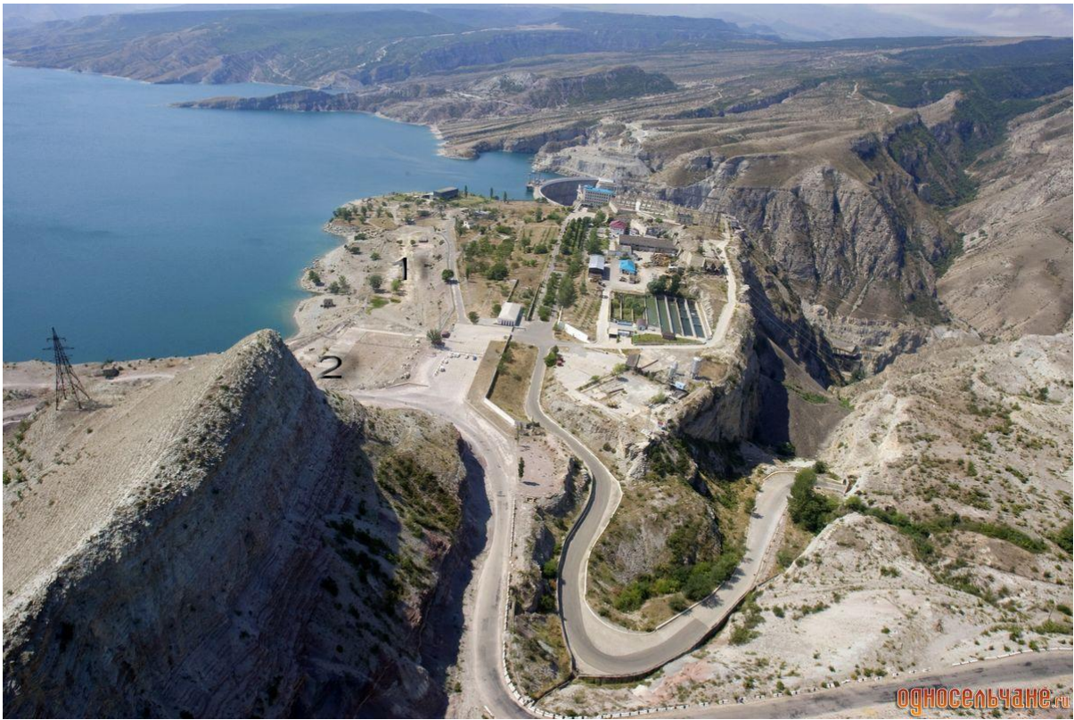
Рис. 3.1.2. Фото участка правого борта плотины Чиркейской ГЭС (цифрами 1 и 2 отмечены места расположения устьев скважин).
