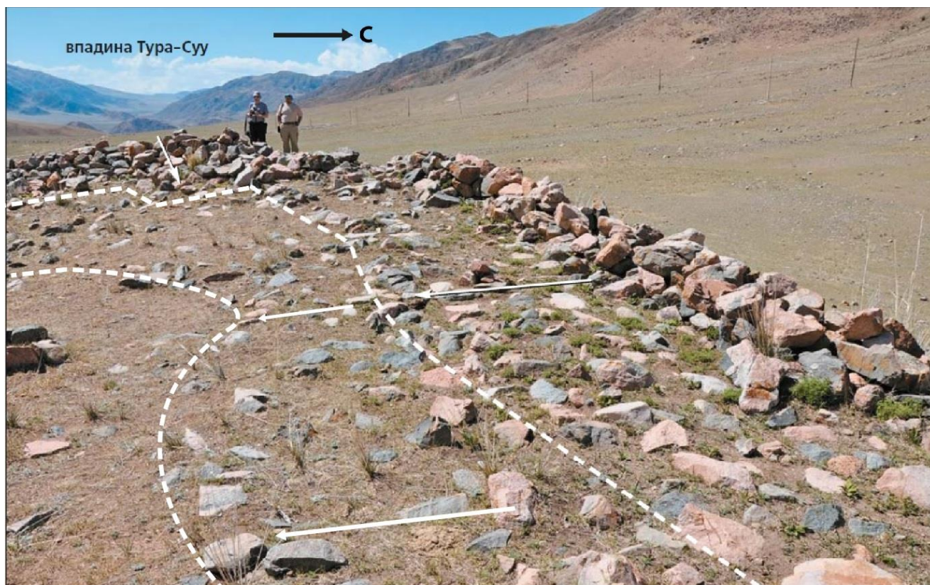
Рисунок 3.11. Обрушение на юге северной стены Ала-Башской крепости (показано длинной стрелкой). Штриховой линией обозначены обломки верхней части стены, образовавшиеся при ее ударе о землю. Западная стена обрушилась в восточном направлении (показано короткой стрелкой). Вид на запад (А.М. Корженков, ..., А.А. Стрельников, ... и др., 2018)
