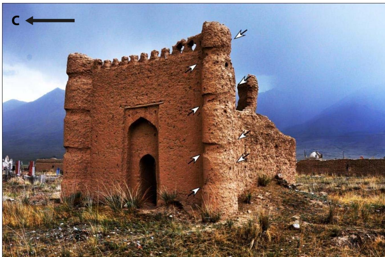
Рисунок 3.13. Систематические наклонные срезы в северо-западной колонне одного из надмогильных памятников села Конур-Олен – следы древних повреждений (А.М. Корженков, ..., А.А. Стрельников, ... и др., 2018)
