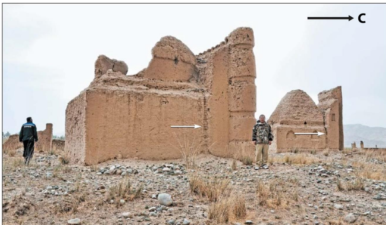
Рисунок 3.14. Отделение и небольшой наклон к северу фронтальных частей всех древних кумбезов Конур-Олена к северу – к Коконадыр-Тегерекскому разлому (А.М. Корженков, ..., А.А. Стрельников, ... и др., 2018)
